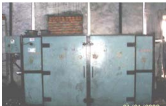
蒸汽管道修改（取消电加热）
