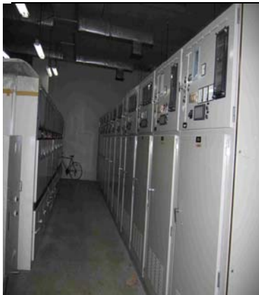
Gambar1: Modifikasi tie bus dari NO menjadi NC
