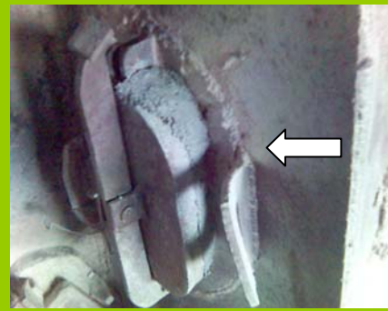
Preheaters sesudah perbaikan
