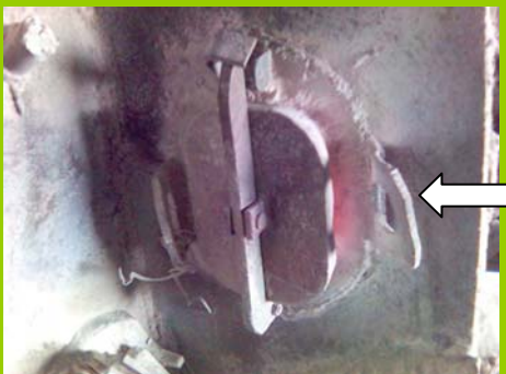
Preheaters sebelum perbaikan
