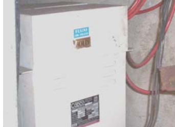
Lắp đặt tụ điện
