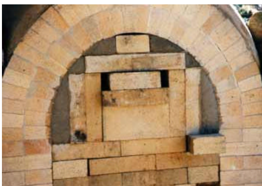
图 2a.窑炉拱门的耐火炉衬 (BEE, 2005)
